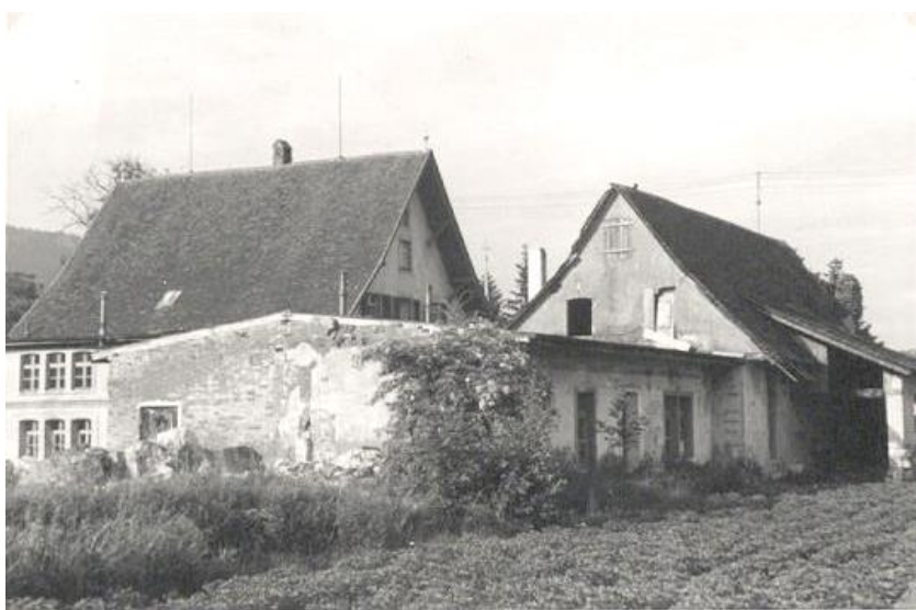
Die Schälismühle nach der Dünnernkorrektur im Jahre 1943. Ein baufälliges Gemäuer, das seinen Zweck längst verloren hat.
