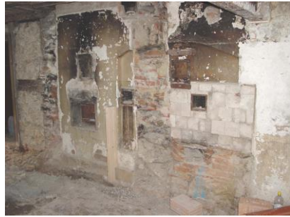
Abbruch der Feuerstelle
