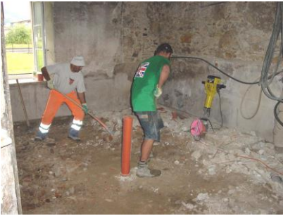
Küche: Boden ausbrechen
