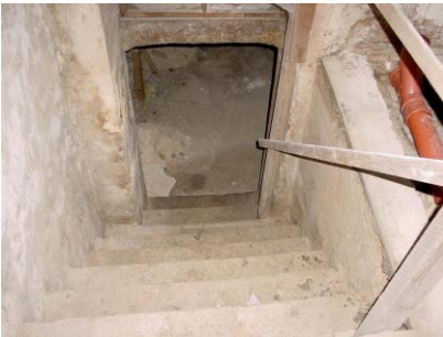
Treppe zum Kellerraum
