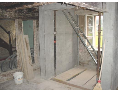
Einbau der Liftanlage bis zum Dachstock
