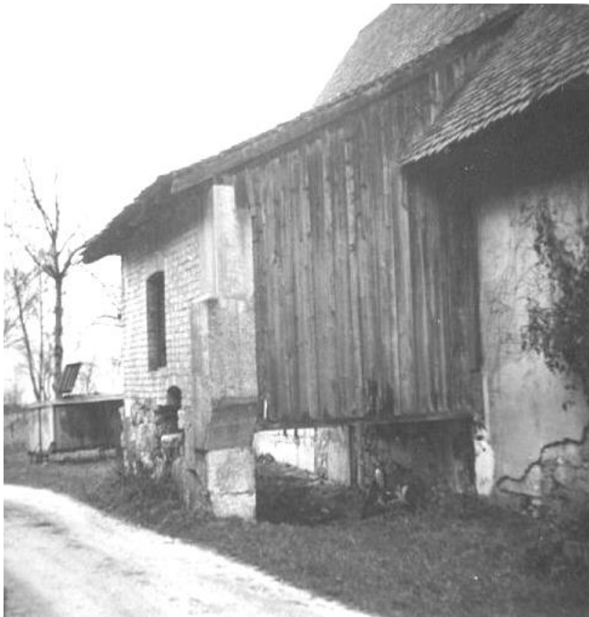
Die Schälismühle mit dem Wasserradkasten 1967
