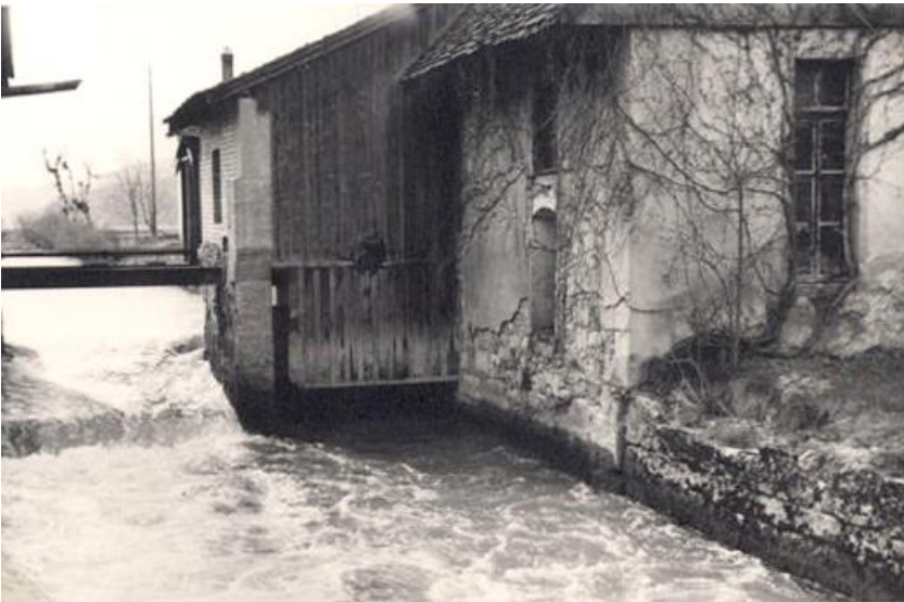
Ansicht im Frühling 1939 Die Schälismühle mit dem Wasserradkasten
