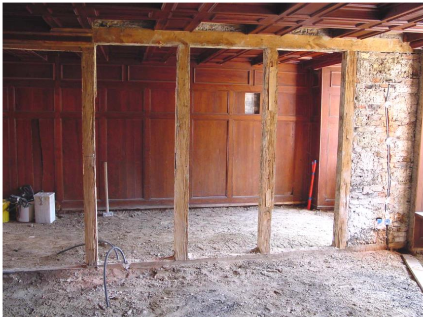
Teilweises Entfernen der Zwischenmauer in der Adam Zeltner-Stube
